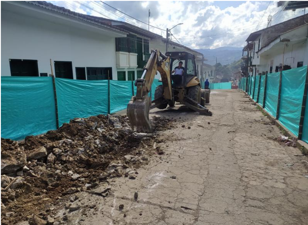
Ilustración 6: Señalizaciones y barreras de seguridad
