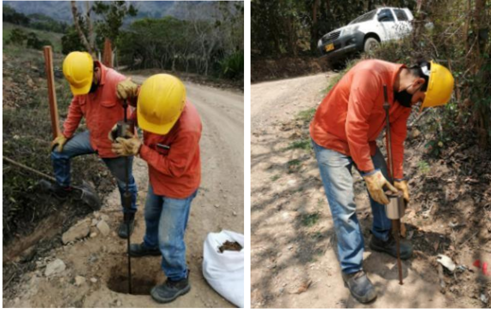
Figura 16 Ensayo de penetrómetro de cono dinámico ejecutado en campo.
