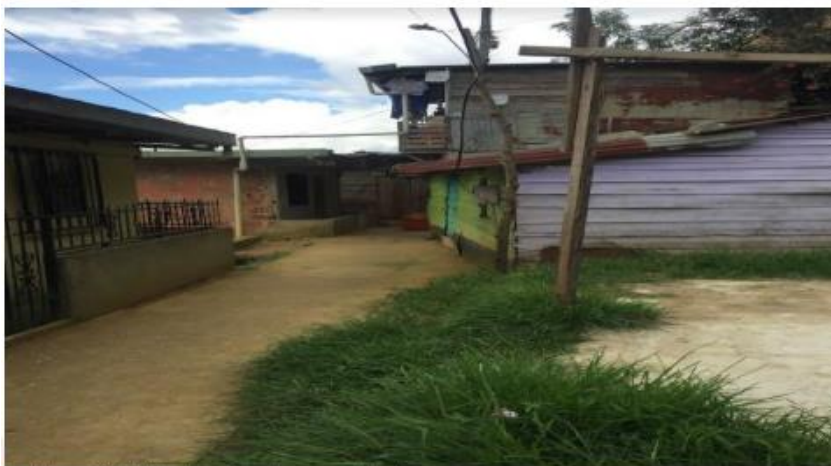
Figura 443. Viviendas y vías de acceso, foto 1.
