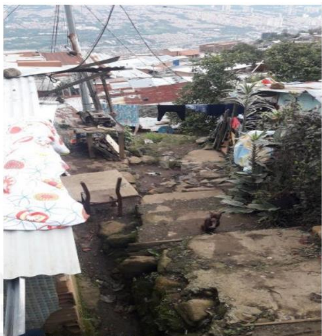
Figura 446. Viviendas y vías de acceso, foto 4.
