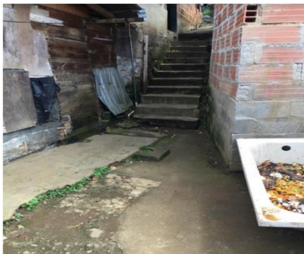
Figura 444. Viviendas y vías de acceso, foto 2.
