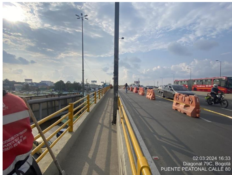
Ilustración 9: Puente Peatonal existente, desde el centro del galibo
