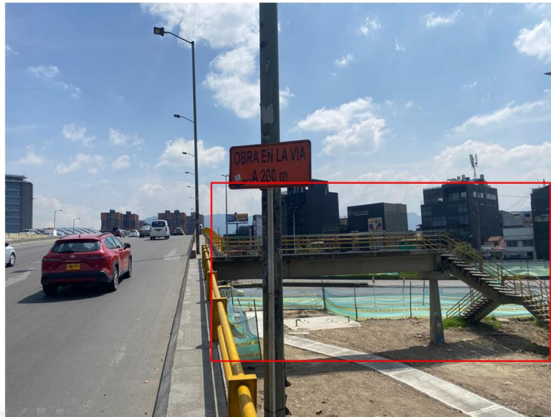
Ilustración 8: Accesos a puente existente costado sur-occidental
