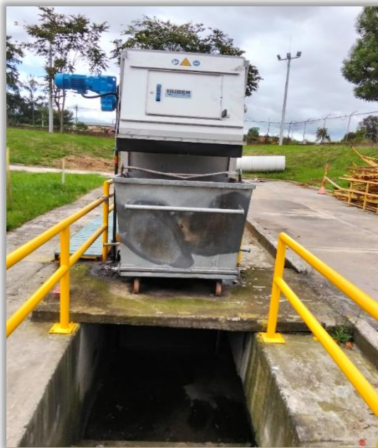
Imagen 2. Maquina Limpia Rejas Agua Residual
