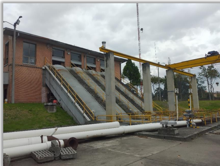
Imagen 4. Tornillos de Arquímedes
