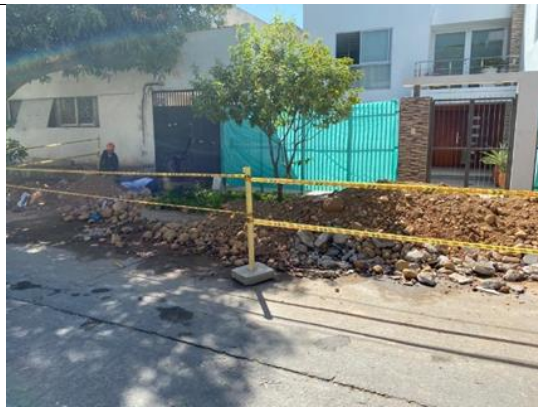
Figura 6. Demolición de pavimento durante actividades constructivas.
