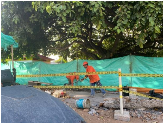
Figura 32. Actividades de limpieza en frente de obra.
