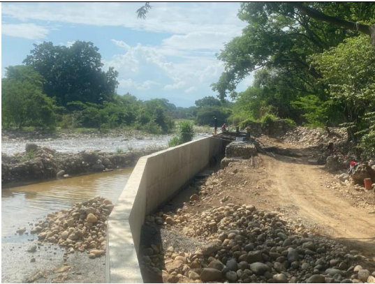
Figura 3. Descole del colector, actividades en ronda hídrica del río Guatapurí.
