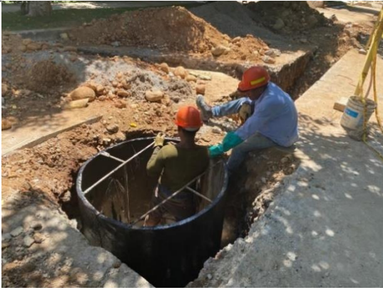
Figura 7. Trabajos sobre cámara de inspección de alcantarillado.
