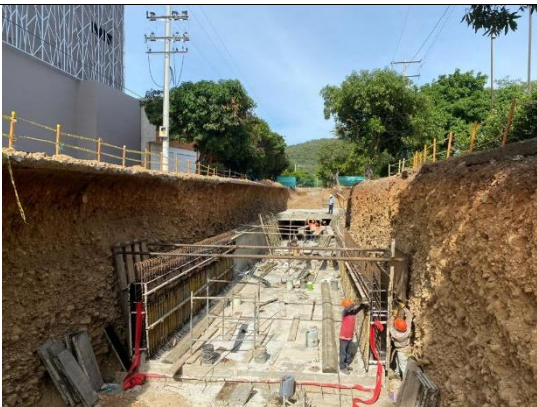
Figura 5. Desarrollo de actividades constructivas en área de excavación abierta.
