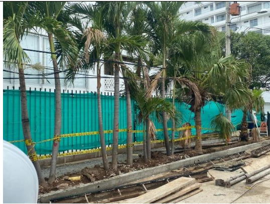
Figura 4. Presencia arbórea en calle 7c por donde pasará el box coulvert.
