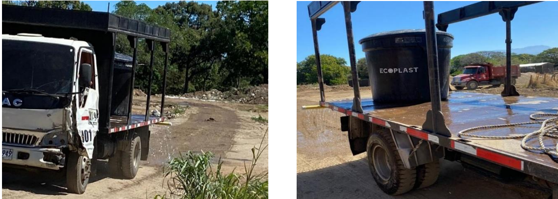
Figura 27. Riego de zonas despavimentadas en área de actividades constructivas del proyecto.
