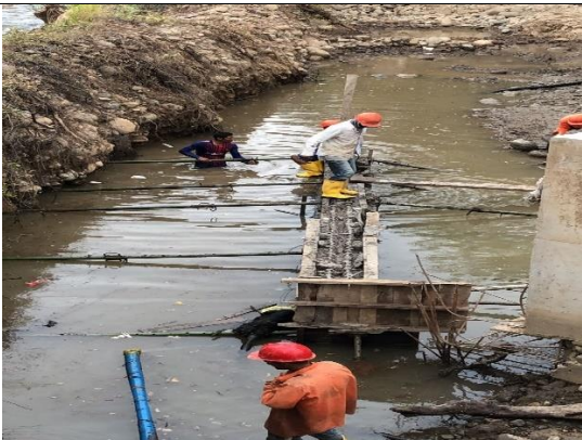
Figura 9. Armado y fundida de muros en ronda hídrica del río Guatapurí.
