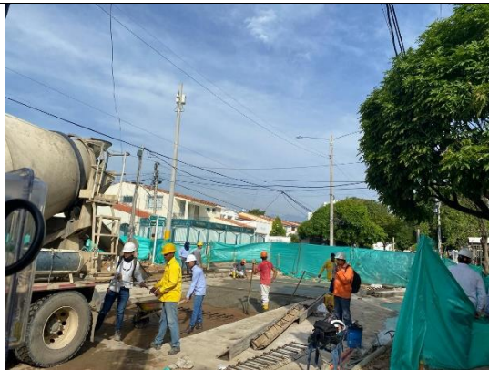
Figura 10. Fundida de losa inferior del box Culvert.
