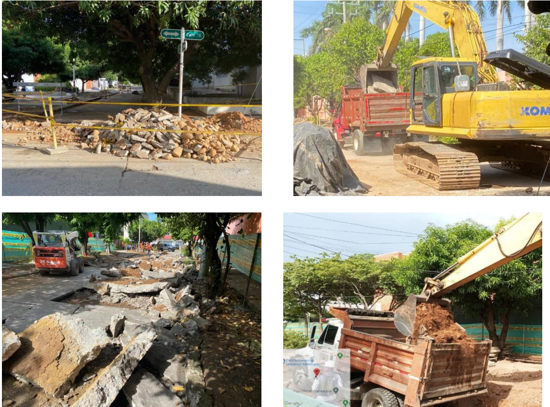
Figura 29. Demolición y transporte de pavimento hacia sitio de disposición.
