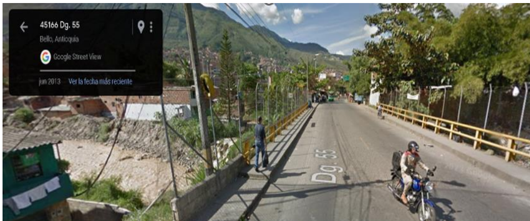
Figura 6: Puente de la 55
