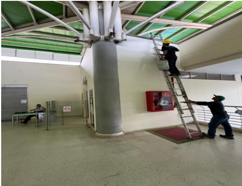
Figura 36. Acompañamiento en trabajo de alturas. Elaboración propia (2025).
