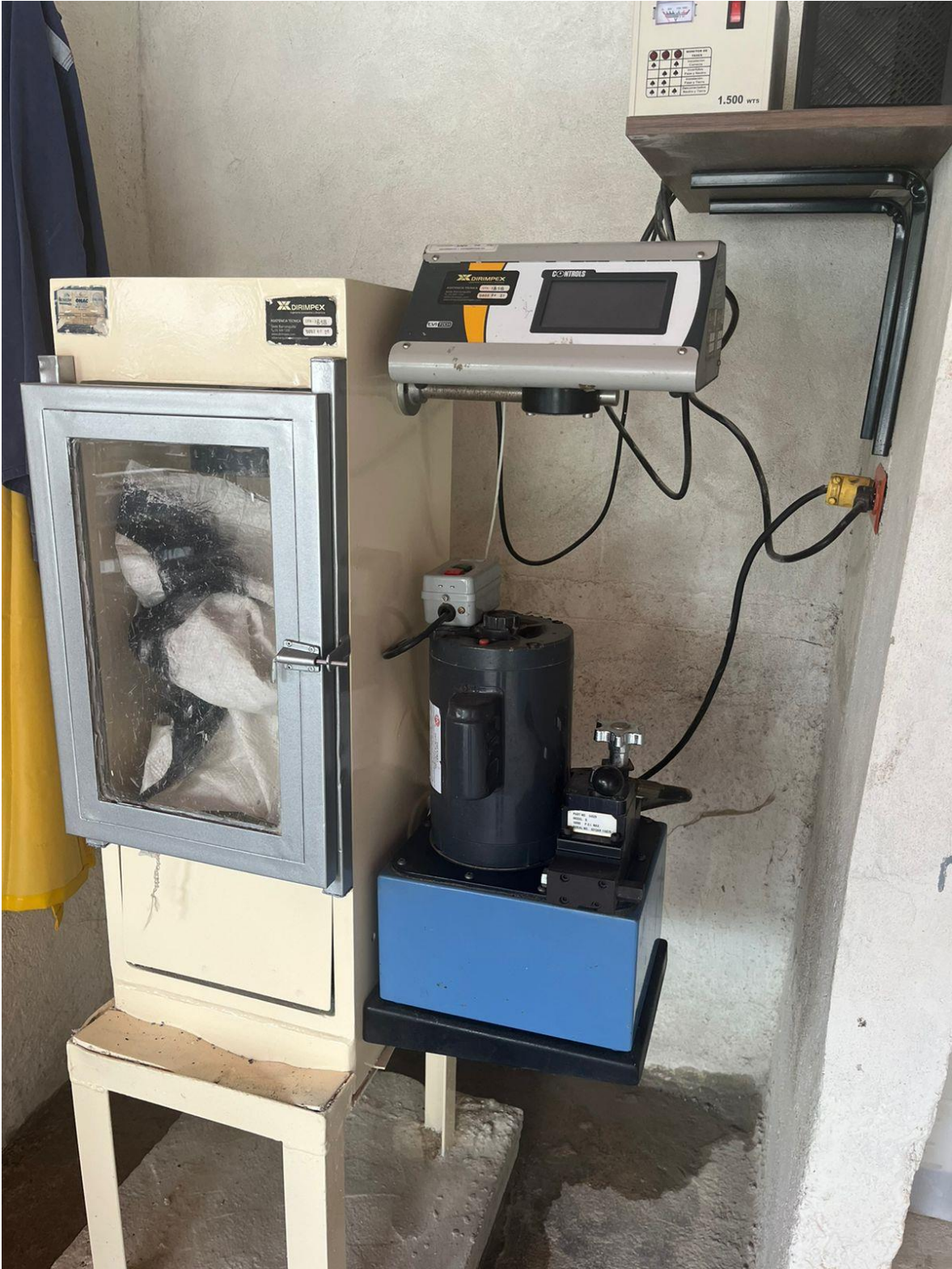
Figura 9. Ensayos de resistencia a la compresión (NTC 673)
