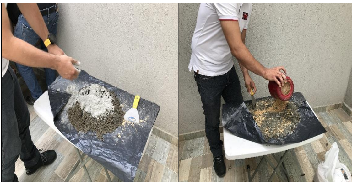
Ilustración No 35. Mezclado de materiales de acuerdo a las dosificaciones establecidas para ladrillos Fuente: Autores.
