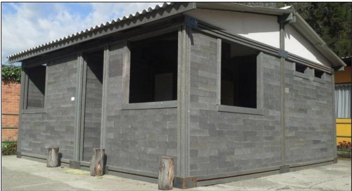
Ilustración 7: Las casas de ladrillos de plástico tipo LEGO que podrás construir tú mismo. Fuente: (Construyored, 2017)
