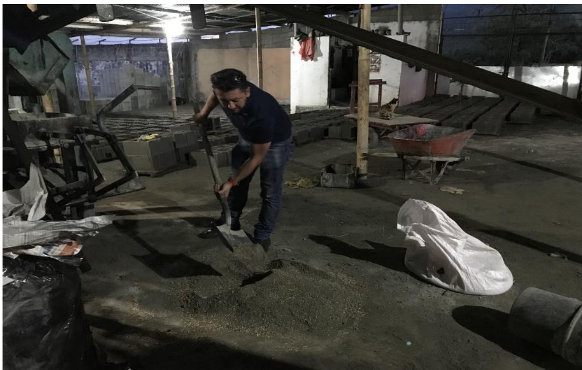
Ilustración No 36. Mezclado de materiales de acuerdo a las dosificaciones establecidas para bloques
