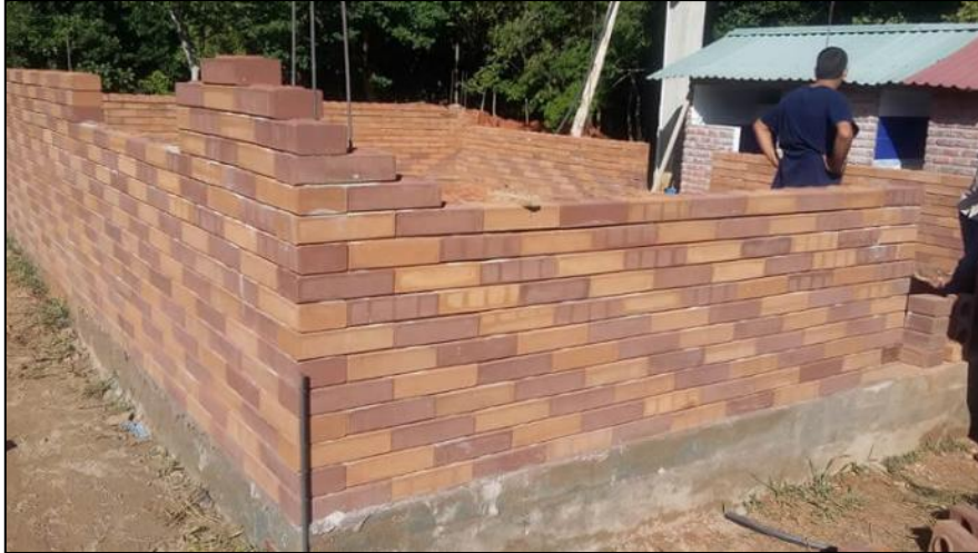
Ilustración 5: ladrillos ecológicos y al estilo Lego se construye en Casanare Fuente: (Rivera, 2018)
