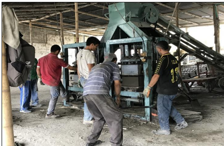
Ilustración 19. Vibrado y moldeado
