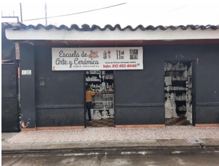
Fachada de la Escuela de Arte y Cerámica
