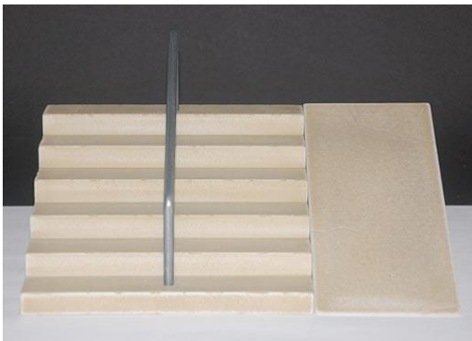
Rampa y barandilla de ayuda al acceso a la escalera a personas con discapacidad
