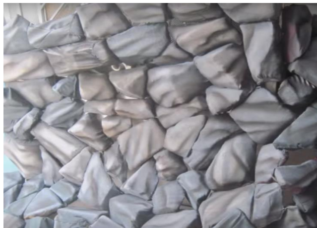
Ilustración 21. Fotografía. Terminación de muro
