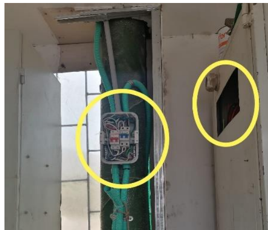
Figura 38. Inspección de riesgo eléctrico. Fuente propia 2024
