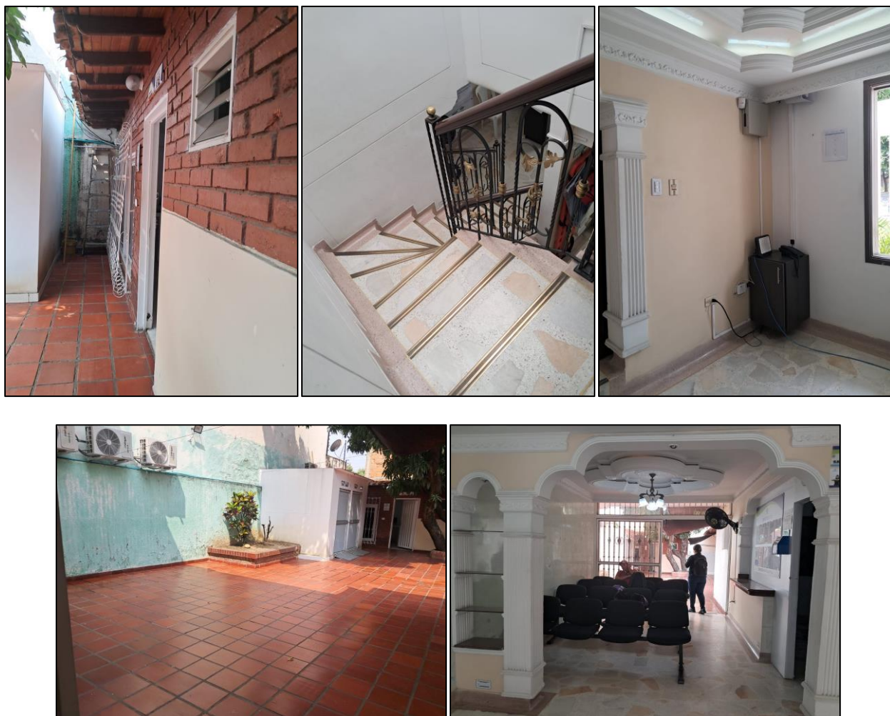
Figura 4. Evidencia fotográfica de la inspección realizada
