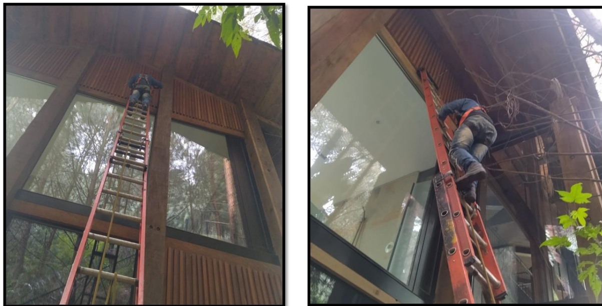
Ilustración 5 “Trabajo en altura de auxiliar eléctrico de SEITTEC S.A.S”
