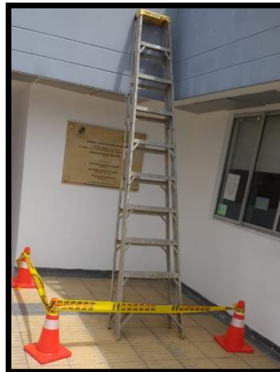
Figura 35. Señalización Zona de trabajo (acceso a terraza).
