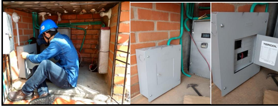
Figura 37. Instalación de punto de control. Fuente: Autores
