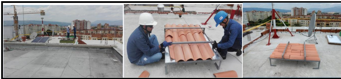
Figura 36. Inspección y montaje de la base es la ubicación seleccionada.
