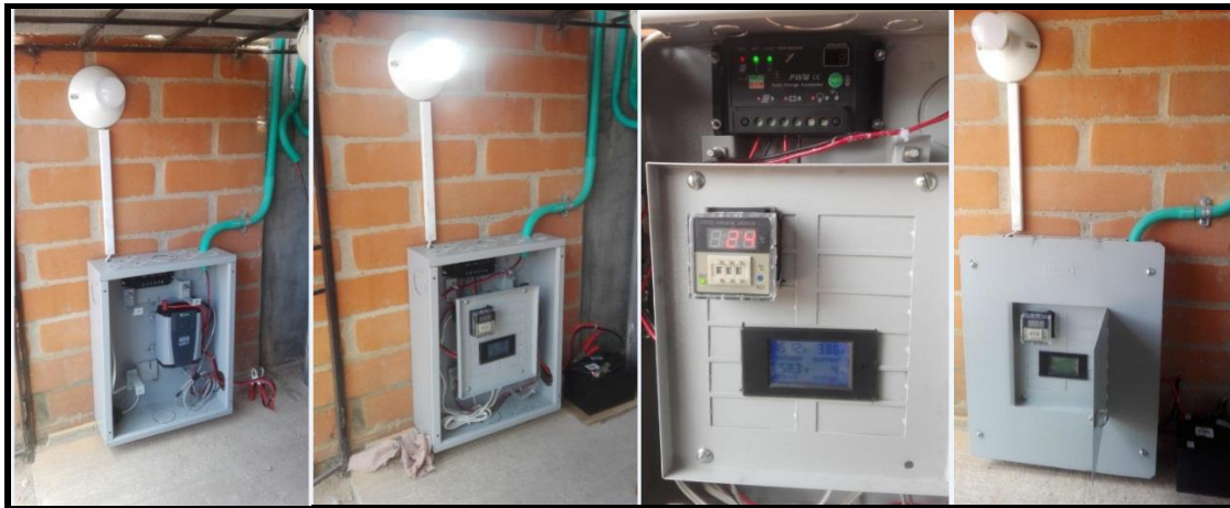
Figura 38. Instalación y pruebas de los instrumentos de medida. Fuente: Autores
