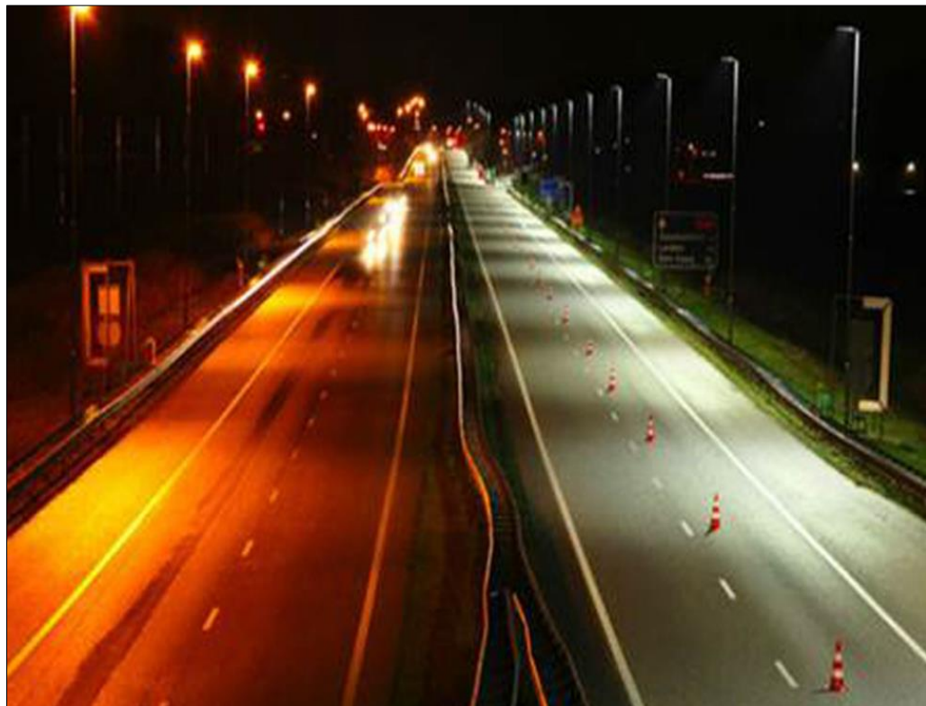
Ilustración 3 - Luminarias Sodios Vs Luminarias LED
