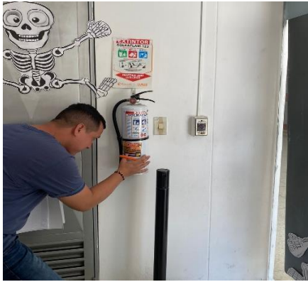
Figura 28 Inspección de Extintores Fuente: Elaboración Propia 2024
