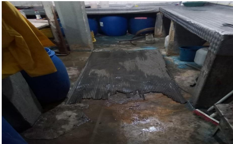
Imagen 5. Condiciones inseguras de la planta.
