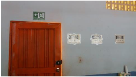
Establecimiento de las señales requeridas en las instalaciones de la sede
