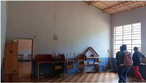
Instalaciones de la sede Manuela Beltrán en la primera intervención
