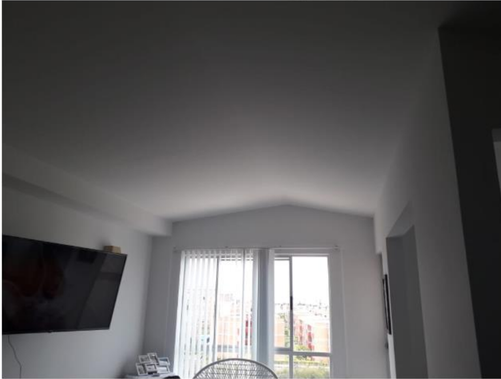
Ilustración 21 Fotografía de proyectos terminados por CONTRULLANOS DE COLOMBIA
