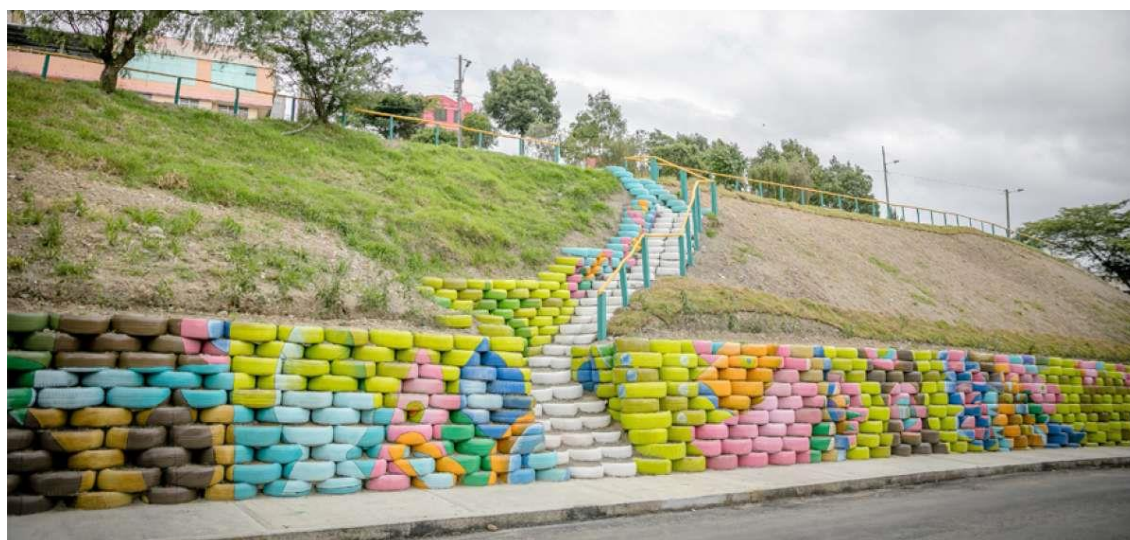
Figura 2. Muros de llantas recicladas
