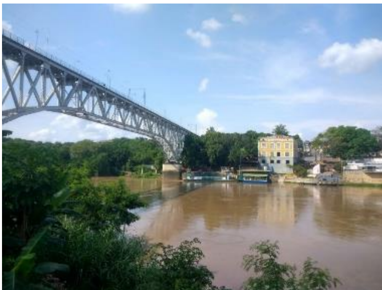
Figura 67 Vista Puente férreo
