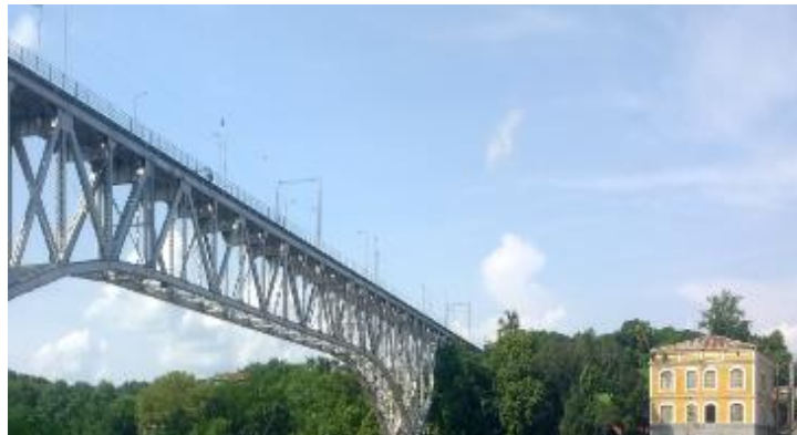
Figura 54 Puente férreo Flandes
