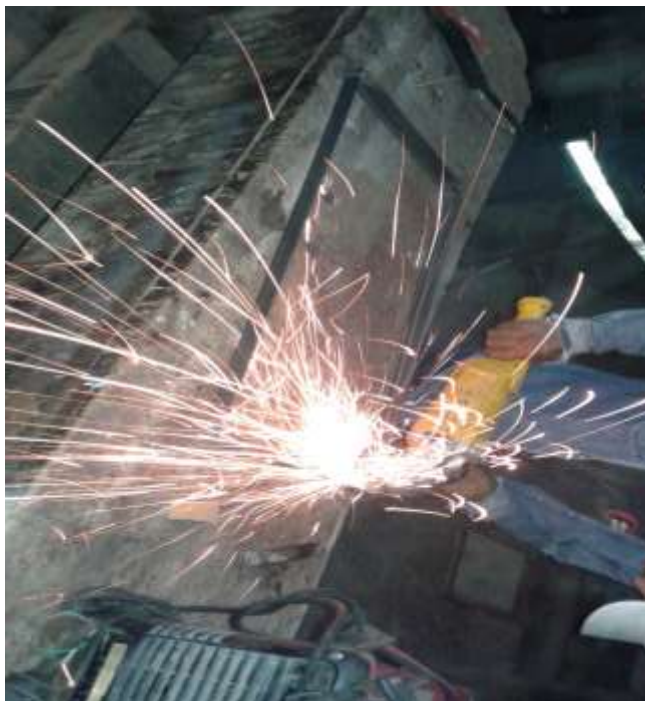
Figura 11. Soldada y pulida de los soportes de los tanques
