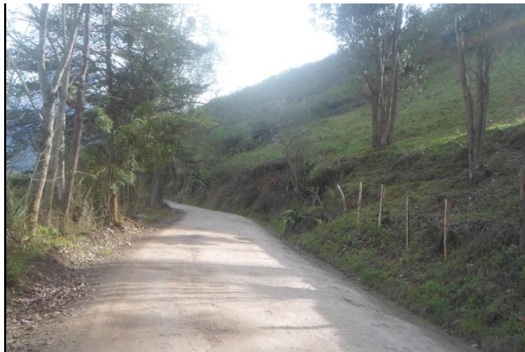
Fotografía 2: Estado de la carretera.
