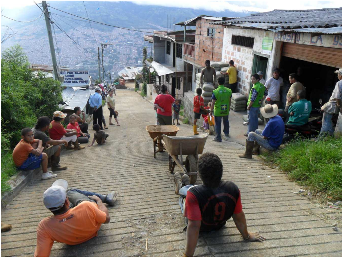
Fotografía 1. Entrega de Materiales Ejecución Mejoramiento de Vivienda Barrio Carambolas Septiembre de 2011.
