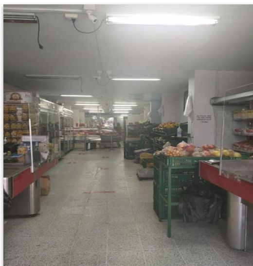
Ilustración 8. Ilustración 6. Evidencia de deficiencia en luminarias
