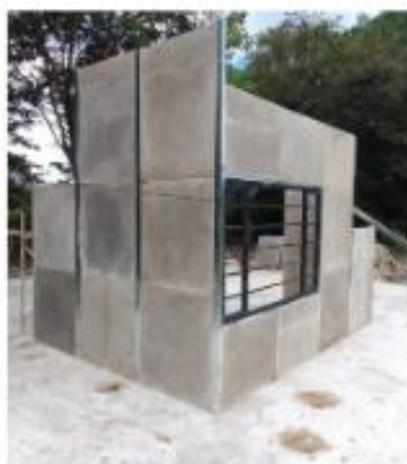
Las placas prefabricadas se ensamblan mediante perfiles metálicos, sobre la placa de cimiento. Se van armando como si fuera un rompecabezas, modulando las paredes con los diversos tamaños y formas de las placas, de acuerdo con el diseño arquitectónico escogido para la casa.
