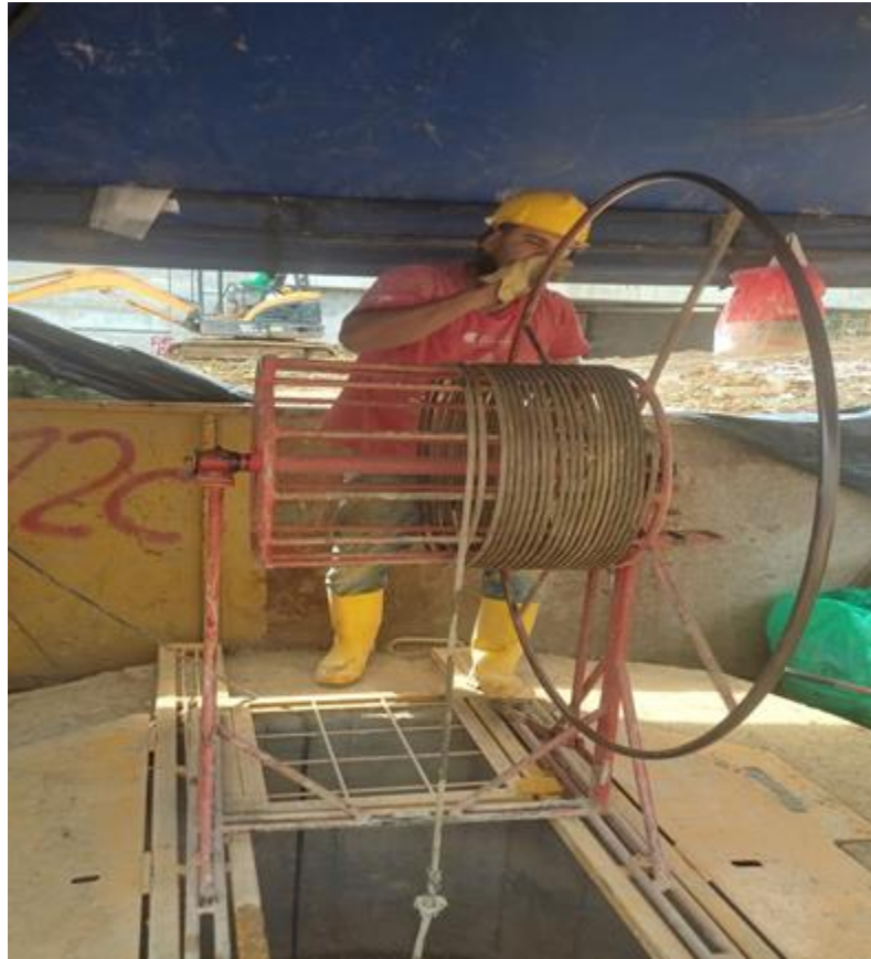
Fotografía 2. Área de trabajo pileros en Constructora Antares
