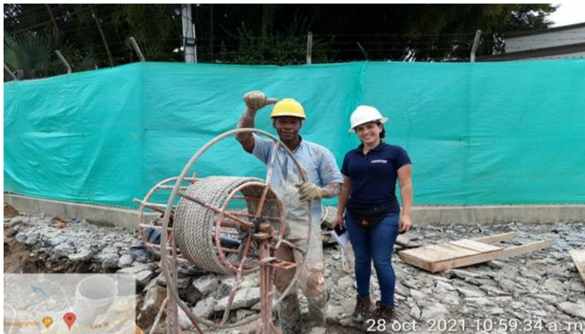
Fotografía 5. Visita de campo
