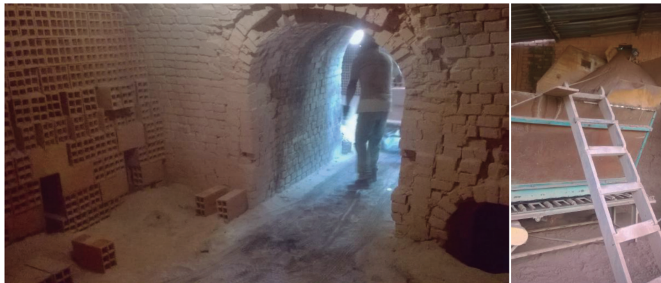
Figura 65. Registro fotográfico de los puestos de trabajo en observación realizada en industrias extractivas del sur de Bogotá
