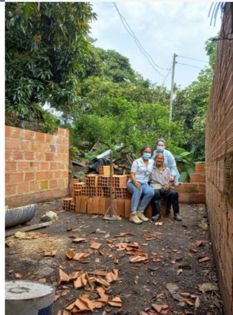
Adelanto del proceso constructivo de la acción solidaria en pro de una vivienda digna.
