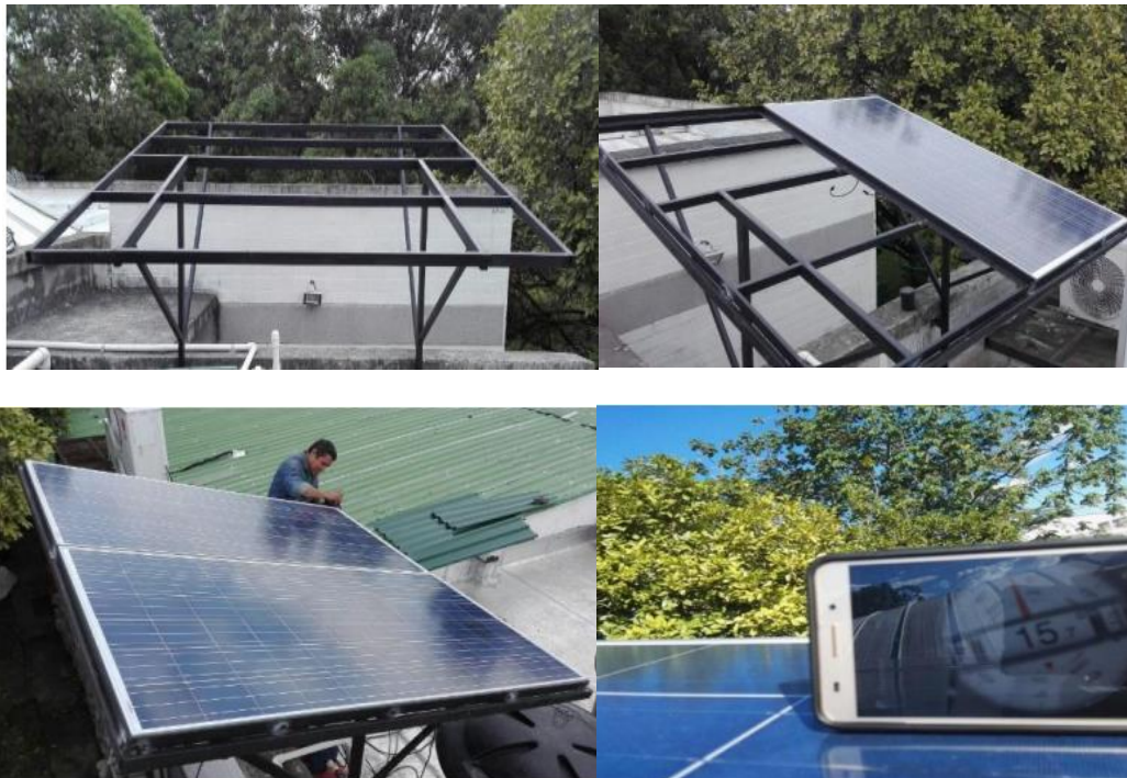
Img 19 INSTALACION DE 2 MODULOS DE PANELES SOLARES POR UNIDAD HABITACIONAL.
