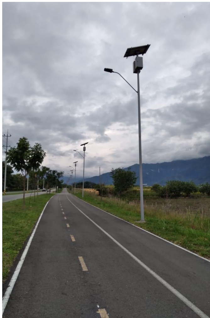
Imagen 8 Alumbrado público led alimentado con celdas fotovoltaicas de la ciudad de Ibagué en la vía al aeropuerto Fuente: Creación propia
