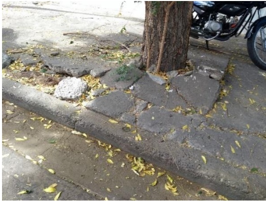
Figura 18. Conflicto arbolado de sendero peatonal con Neem
