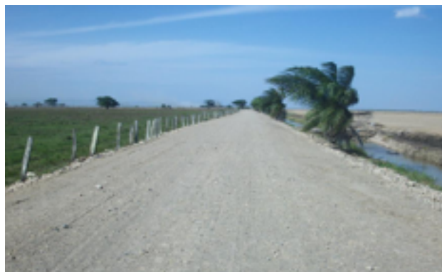
Fotografía 5. Proceso de estabilización mecánica con material granular
