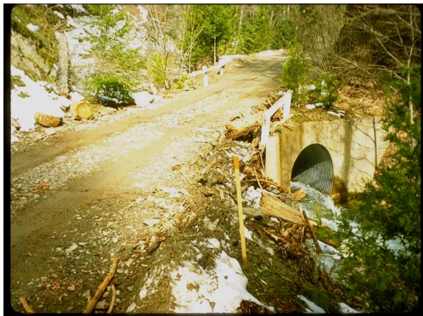
Fotografía 9. Alcantarilla en vía de bajos volúmenes de tránsito
