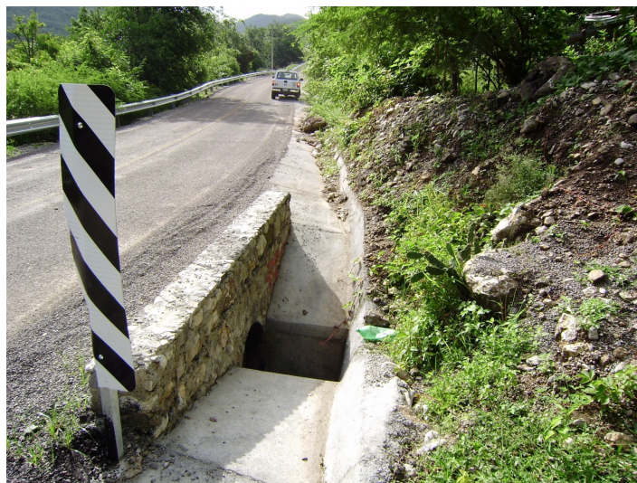
Fotografía 8. Ejemplo alcantarilla poceta-Aleta. Detalle poceta
