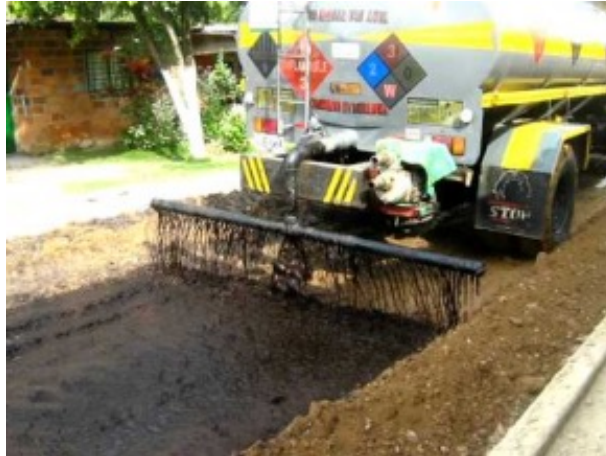
Fotografía 4. Proceso de estabilización con ligante bituminoso
