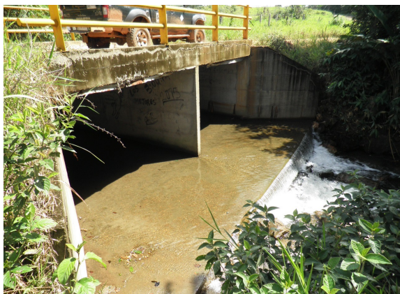
Fotografía 10. Box culvert típico en vías de bajos volúmenes de tránsito
