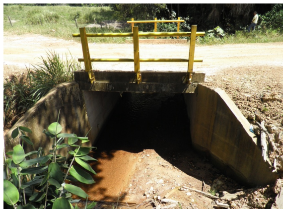
Fotografía 11. Box culvert típico en vías de bajos volúmenes de tránsito
