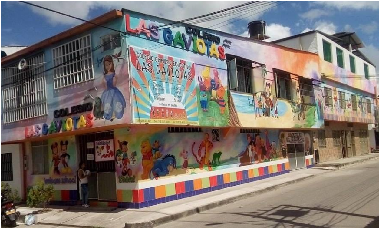
Fachada Colegio Gimnasio Educativo Las Gaviotas.
