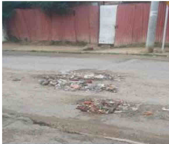
Fotografía. 2. Disposición final de RCD's en relleno de baches en vías, Barrio el Diamante, Girardot (Fuente: Propia, tomada en febrero de 2018)
