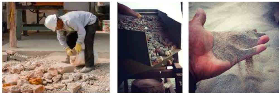
Ilustración 9. Proceso de reciclaje RCD's por empresas en ciclos productivos áridos (Arquitectura, 2016).
