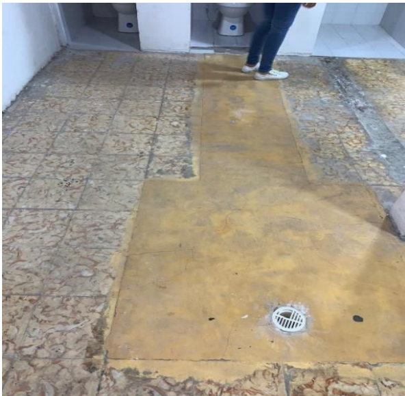
Ilustración 35 Parche de construcción
