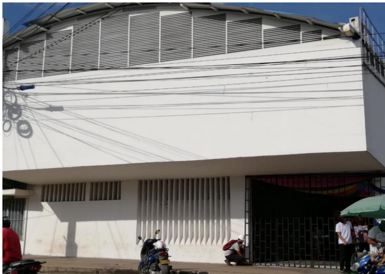
Ilustración 20 Fachada principal del teatro cultural Luis Enrique Osorio
