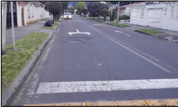
Calle 127 A Carrera 49
