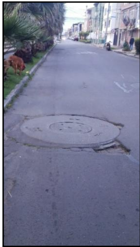
Calle 128 A Carrera 49
