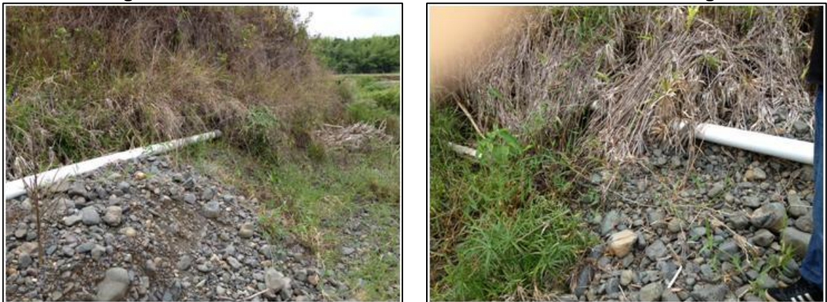
Imagen 5-16. Tubería Aducción desde Bocatoma al Desarenador Antiguo
