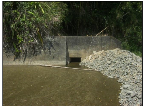
Imagen 5-7. Bocatoma Lateral Río San Marcos
