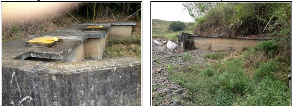
Imagen 5-11. Desarenador Localizado a Continuación de la Captación Lateral
