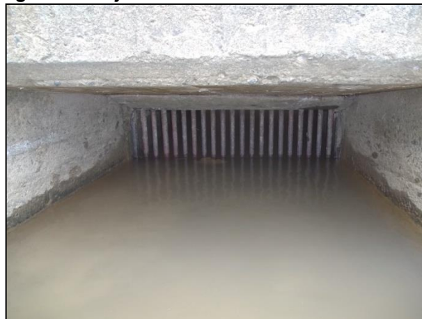
Imagen 5-9. Rejilla Bocatoma Lateral Río San Marcos
