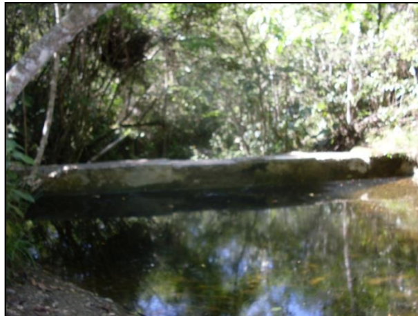
Imagen 5-10. Bocatoma Quebrada Afluente del Río La Paila
