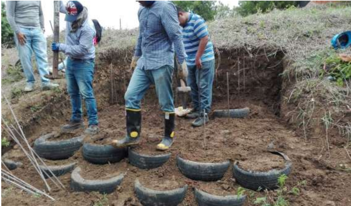
Fotografía 3. Apilamiento y compactación del muro
