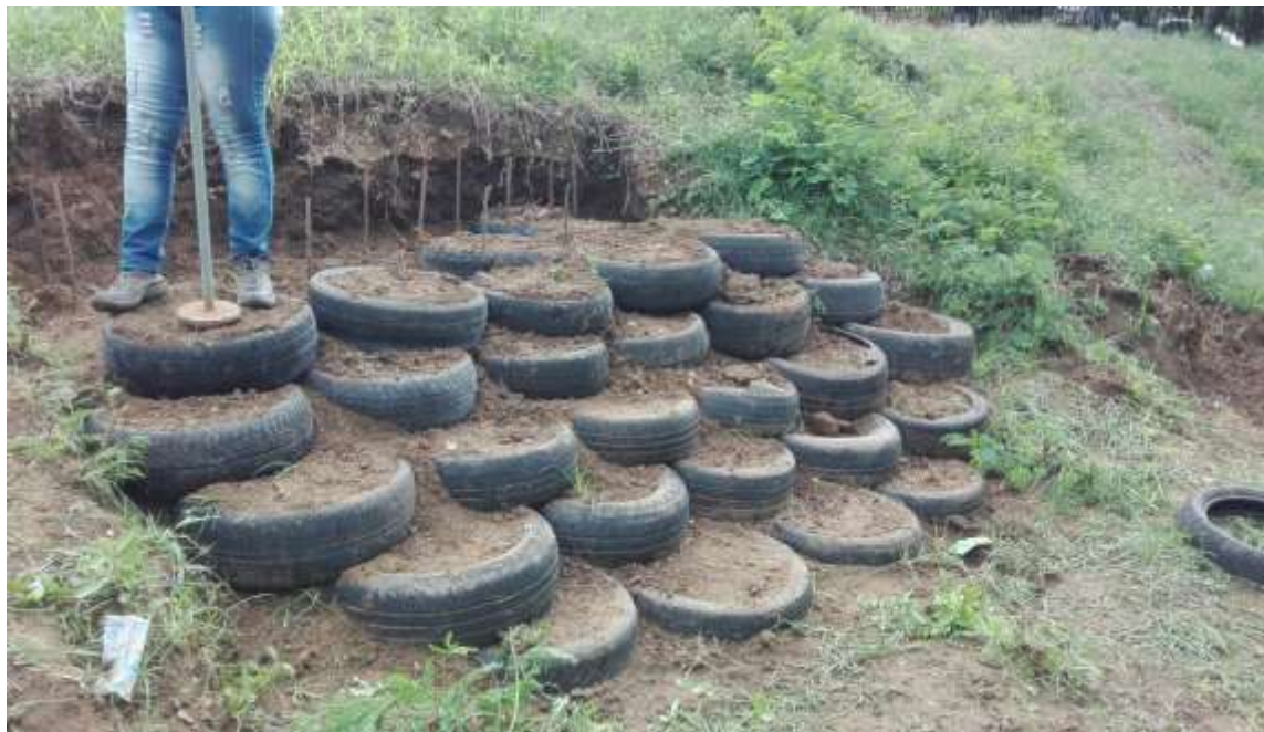
Fotografía 4. Muro de gravedad con llantas
