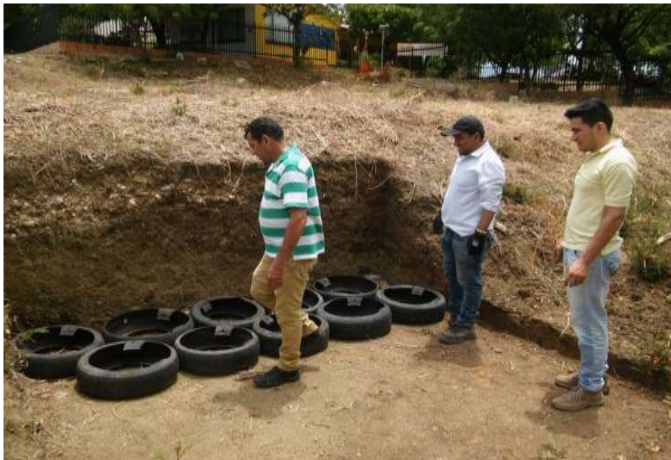
Fotografía 2. Limpieza del terreno e instalación de las llantas
