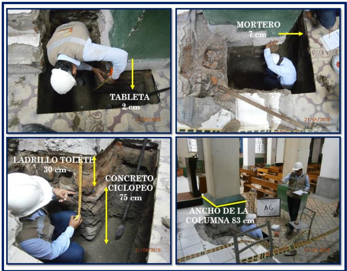
Foto 26. Registro fotográfico del perfil de la cimentación existente.
