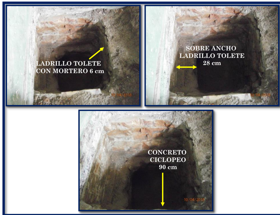
Foto 9. Registro fotográfico del perfil de la cimentación existente.
