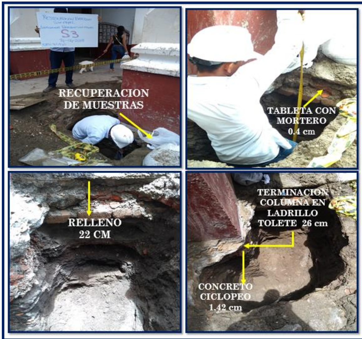
Foto 13. Registro fotográfico del perfil de la cimentación existente.
