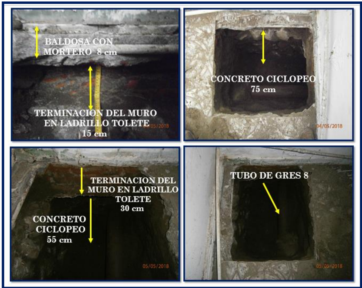
Foto 51. Registro fotográfico del perfil de la cimentación existente
