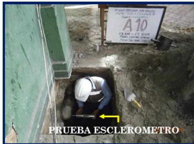
Foto 43. Prueba de esclerometría
