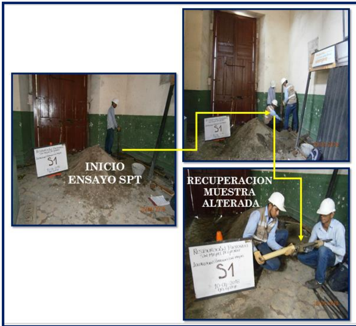
Foto 5. Ensayo de Standard Penetration Test – SPT y recuperación de muestras.
