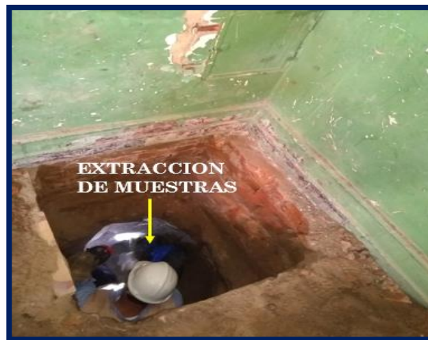
Foto 11. Recuperación de muestras del suelo de cimentación.
