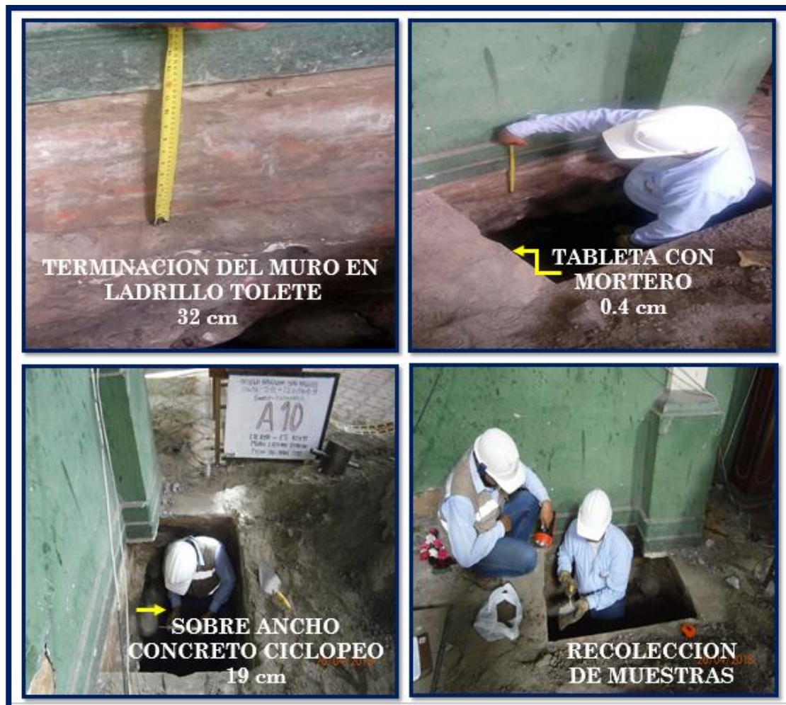
Foto 42. Registro fotográfico del perfil de la cimentación existente
