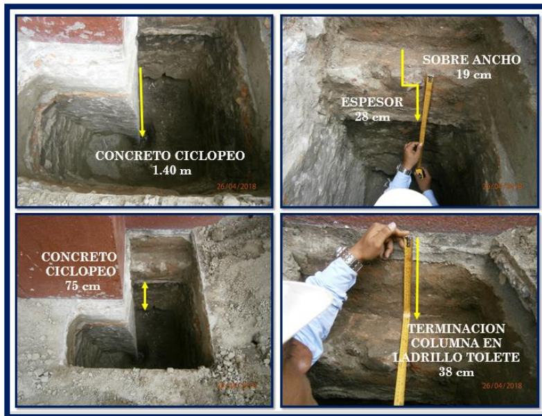
Foto 18. Registro fotográfico del perfil de la cimentación existente
