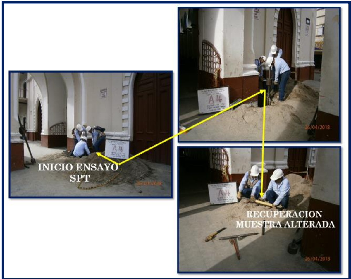
Foto. 20. Ensayo de Standard Penetration Test – SPT y recuperación de muestras.
