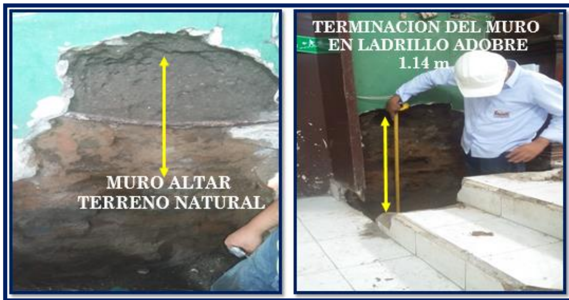
Foto 30. Registro fotográfico del perfil de la cimentación existente.
