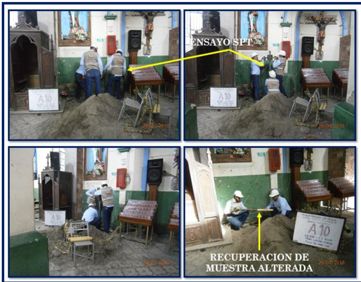
Foto 44. Ensayo SPT y recuperación de muestra alterada.
