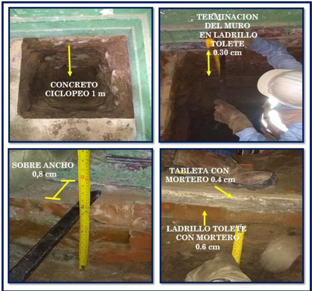
Foto 2. Registro fotográfico del perfil de la cimentación existente.
