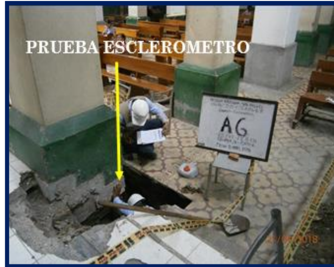
Foto 27. Prueba de esclerómetro.
