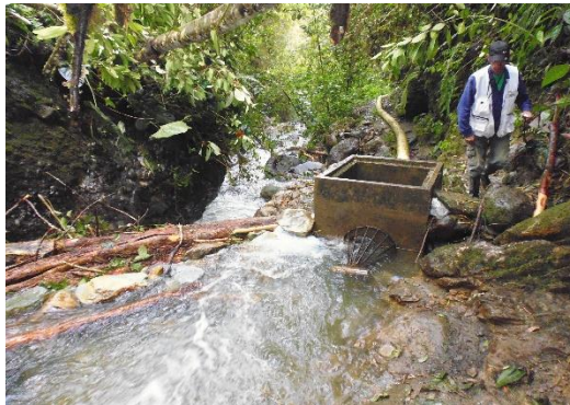
Foto No. 3: Bocatoma Acueducto
