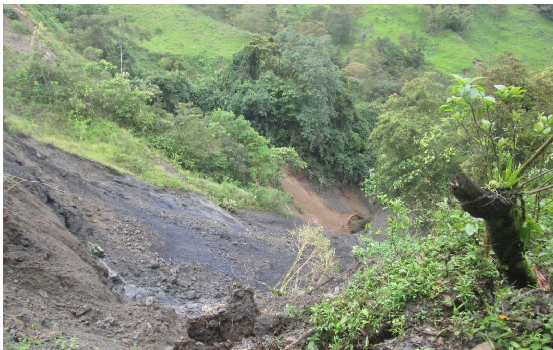
Foto No. 2: Derrumbe de la ladera Qubradablanca Fuente: Luis Arsenio Ramos
