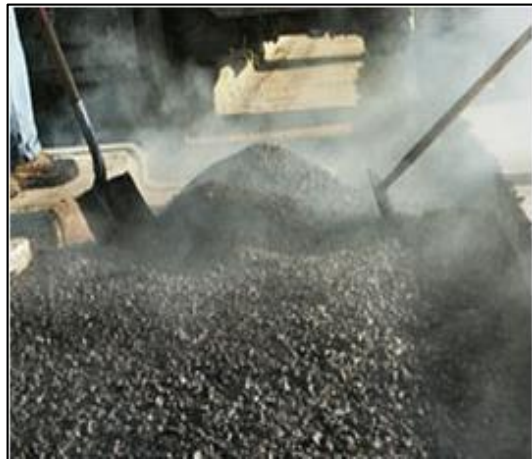
Imágen N° 1. Mezcla asfáltica en caliente
