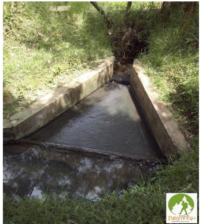
Ilustración 4 toma de agua la piedra
