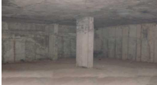
Ilustración 5. tanque Reactor de Pozo Profundo.
