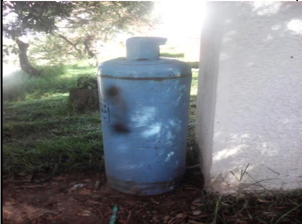
Sin etiqueta de riesgo presente, sin soporte
