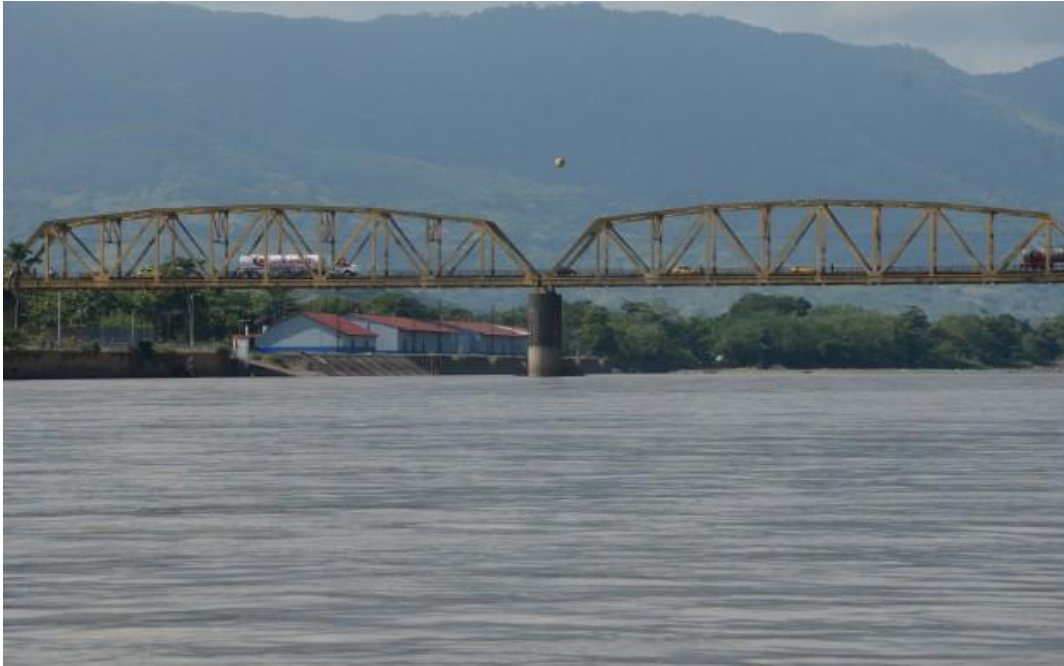
Ilustración 5: Puente vehicular entre La Dorada y Puerto Salgar Tolima
