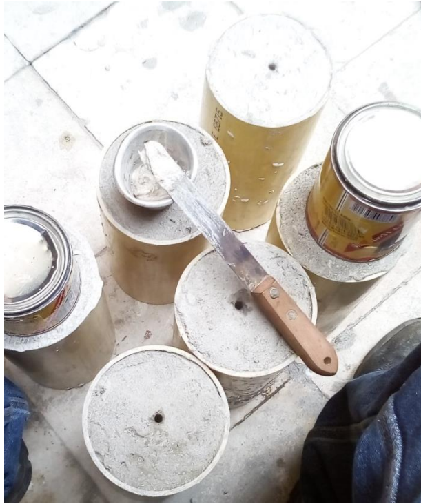
Ilustración 19: Aplicación de soldadura epóxica para instalación de ganchos.
