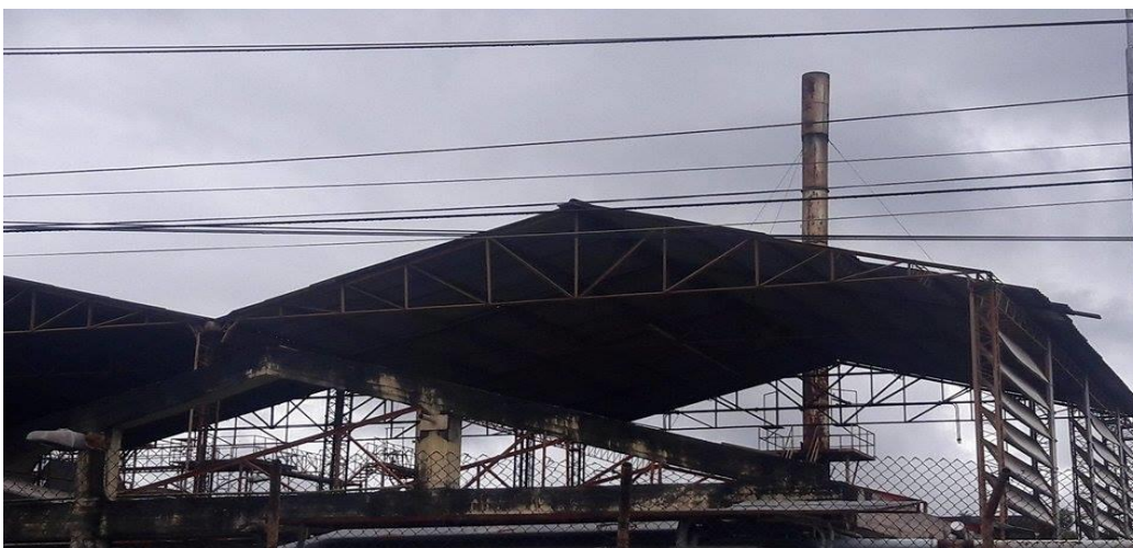
Ilustración 2: Cubierta PROGRAL Girardot Cundinamarca
