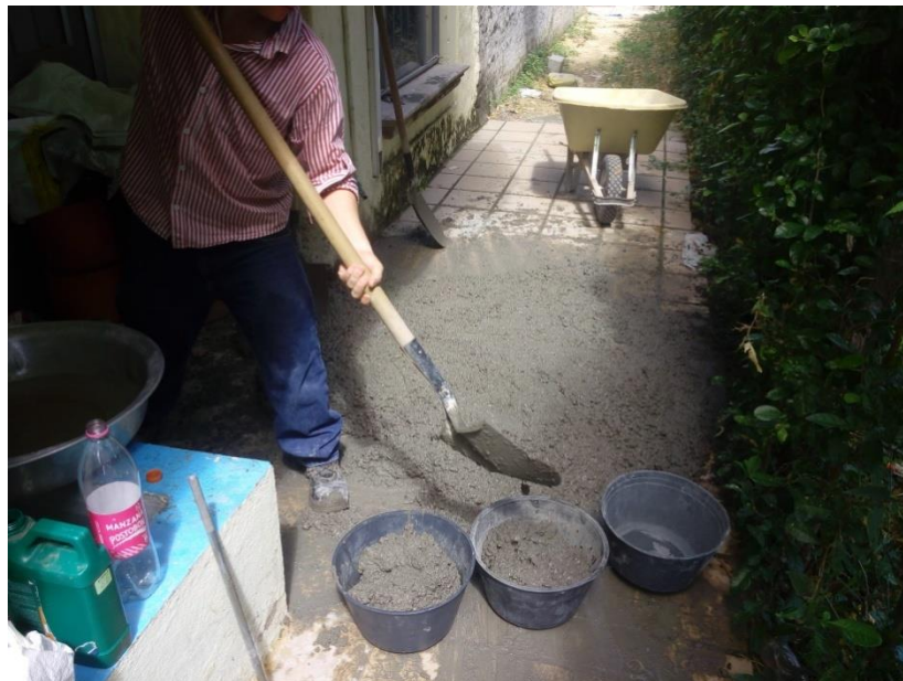
Ilustración 11: Mezcla de materiales para el concreto
