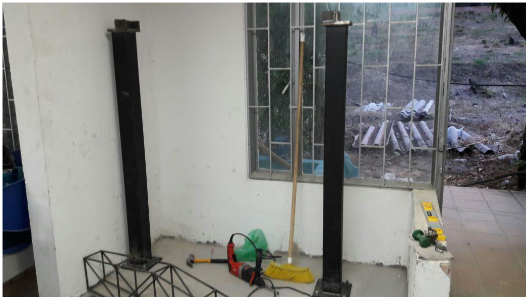
Ilustración 15: Columnas instaladas y ancladas
