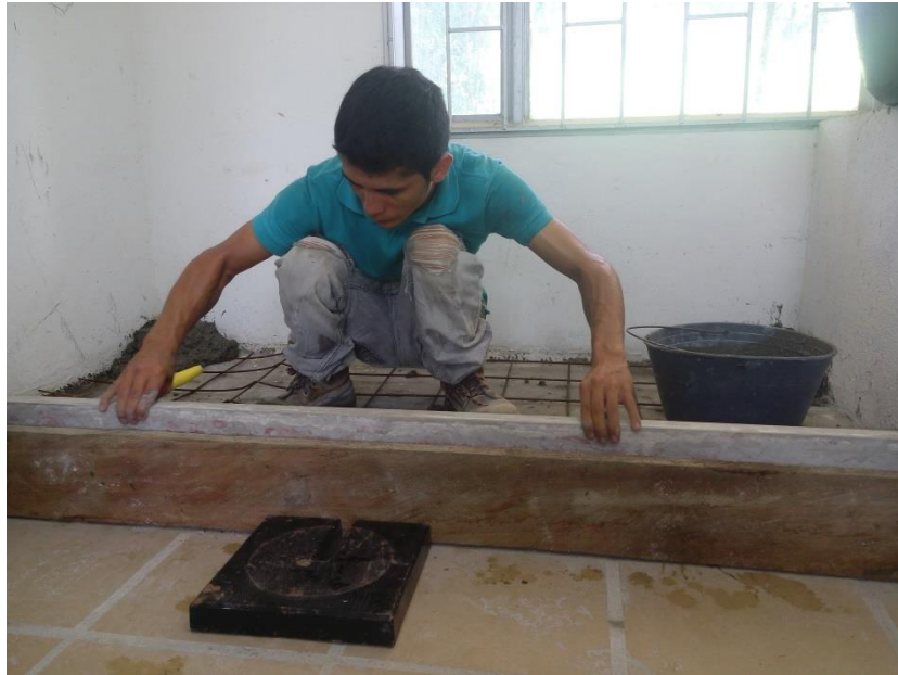
Ilustración 12: Nivelación del concreto con llana metálica
