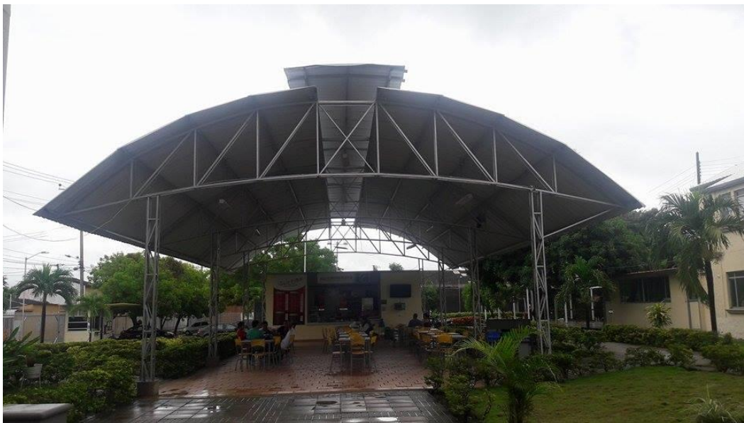
Ilustración 1: Cubierta cafetería Uniminuto Centro Regional Girardot
