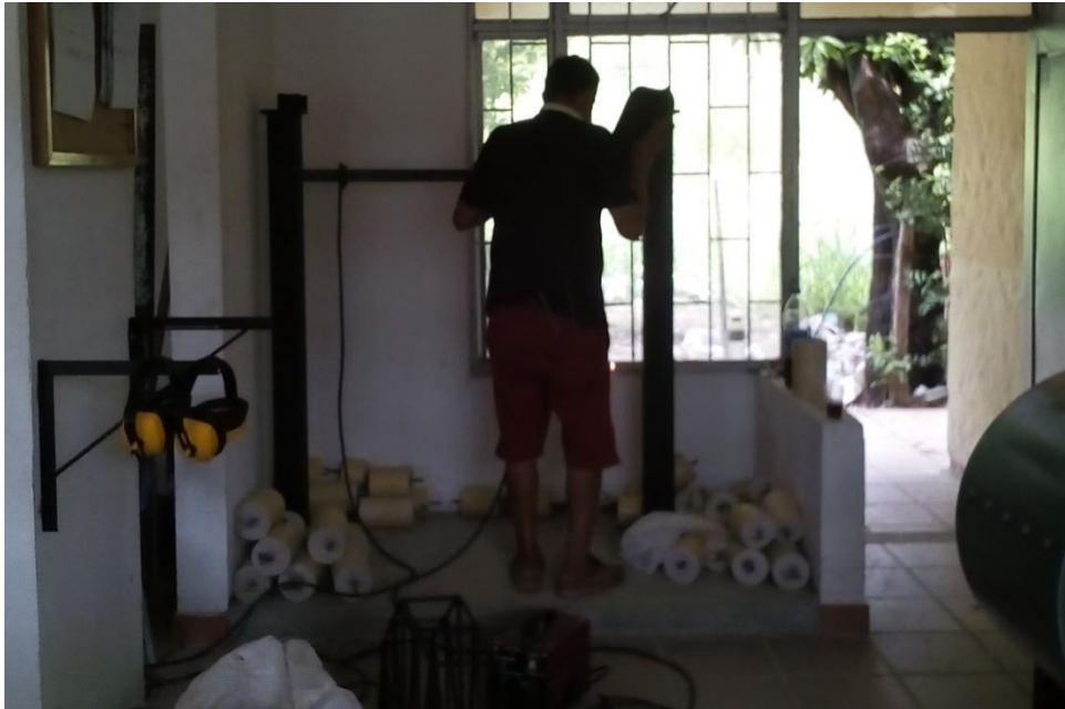
Ilustración 16: Proceso de unión con soldadura del soporte para la base magnética
