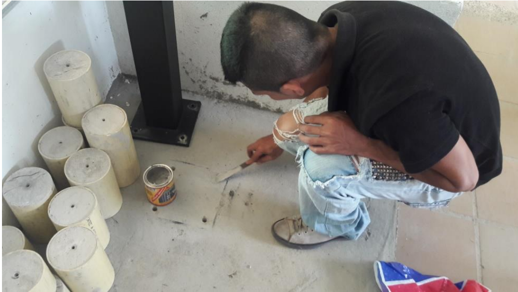
Ilustración 14: Aplicación de soldadura epóxica
