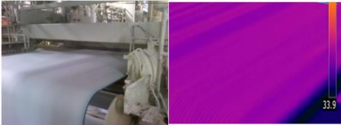
Figura 18. Termografía del punto de aplicación del Air Knife
